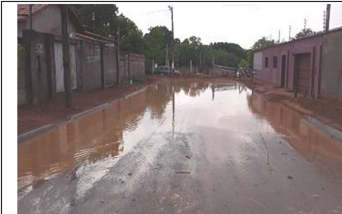
Foto 01 – Rua Princesa Isabel – Setor Novo Horizonte – Execução de meio-fio e sarjeta
