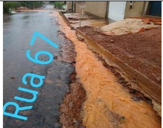
Foto 02 – Rua 67 – Setor Novo Planalto – Execução de meio-fio e sarjeta
